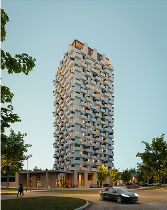
Camellia Tower - projecto da Vizta em Leça da Palmeira
