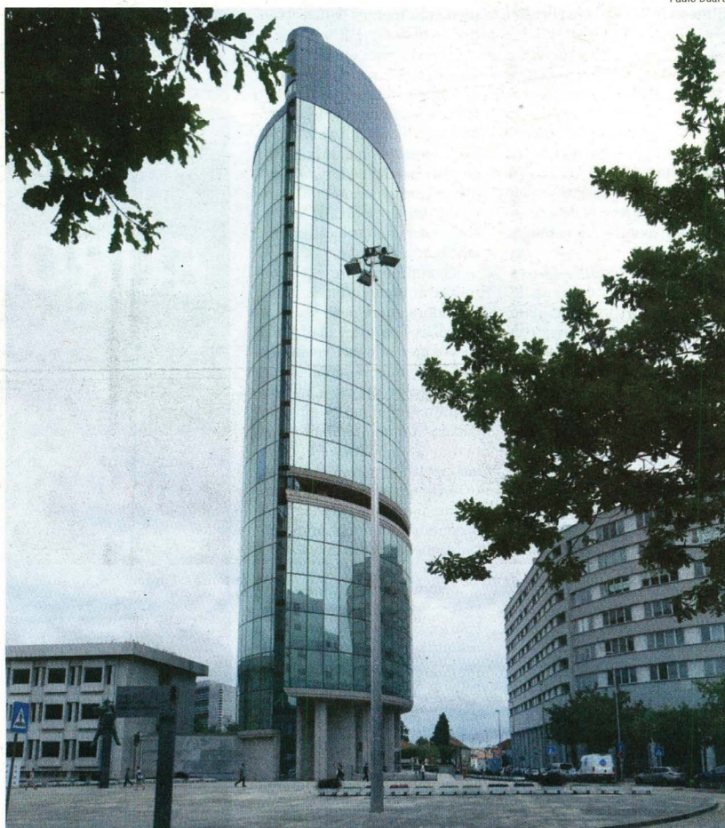
O projeto a desenvolver na cidade da Maia tem uma área de construção prevista de 39 mil metros quadrados.
